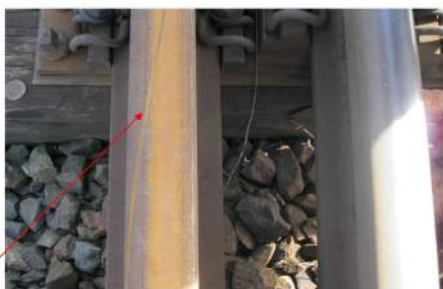
Fig.nr.12 Urma de escaladare (din exteriorul căii) a contraacului curb al macazului 5A de către roata nr. 5
