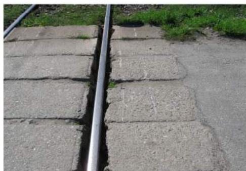
Fig.nr.14 Urmele de deraiere a boghiului peste pasajul de la TN 490+365
